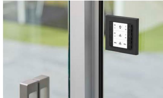
L'intera elettrificazione è fornita da un semplice sistema Plug and Play. Non servono operatori specializzati per far funzionare Bosse cube 4.0. La centralina ha un grado di protezione IP56 (protezione dagli spruzzi d'acqua). La centralina basata sulla tecnologia KNX BUS permette la gestione centralizzata di luci, ventilazione etc.
